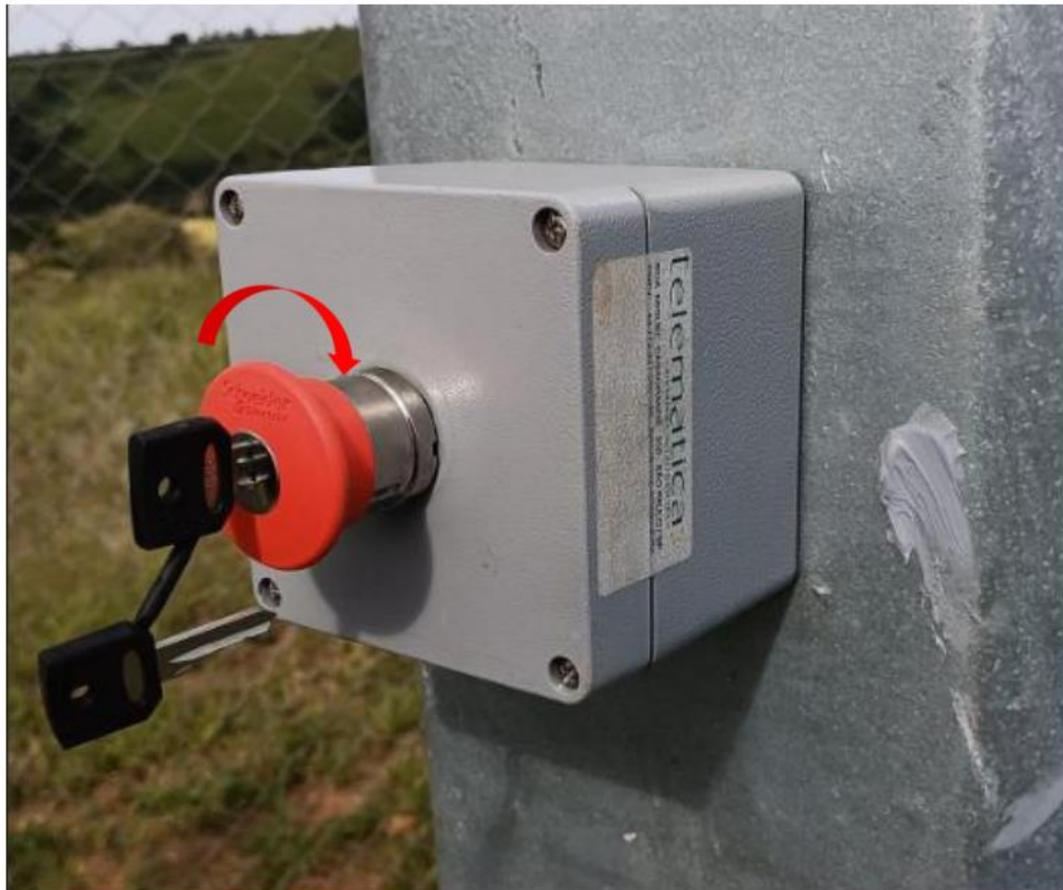
Figura 10.4 - Botoeira de emergência (acionamento manual).
