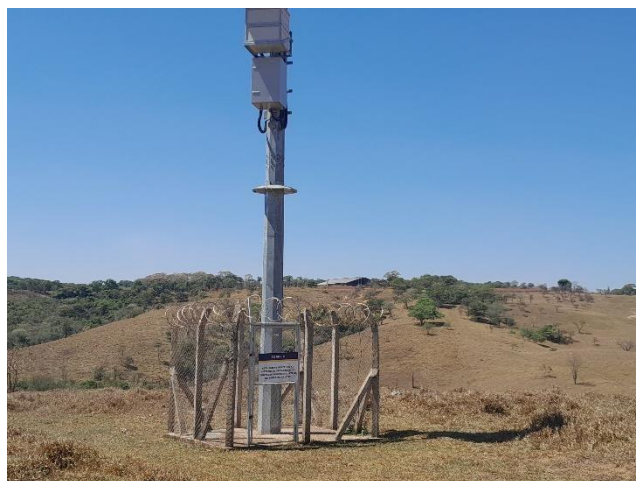
Visita de campo - Instalação da Sirene 06 . Barragem Sabão
