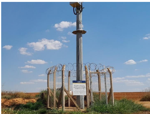
Visita de campo - Instalação da Sirene 05 . Barragem Sabão
