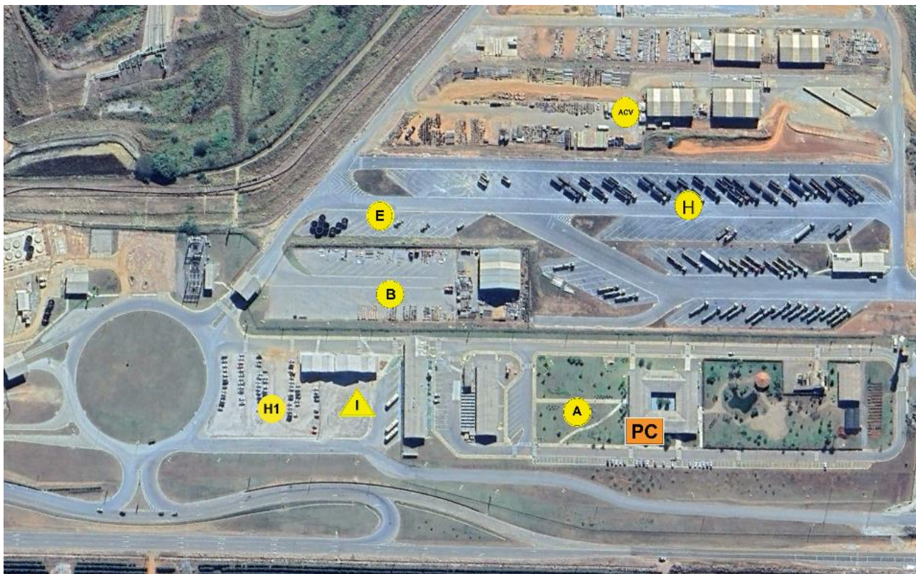
Figura 9.2 - Instalações físicas do SCO - PAE Barragens Sabão I, Sabão II e Jacu - Complexo Minerio Industrial de Serra do Salitre.
