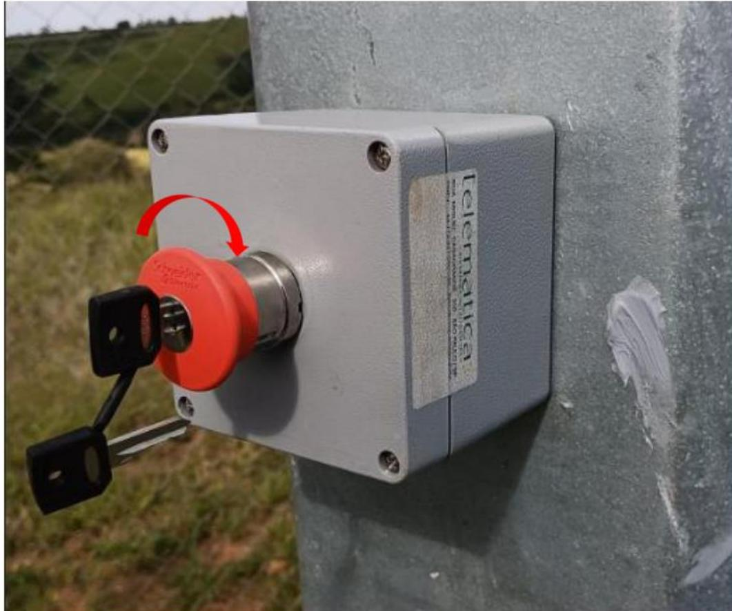
Figura 11.4 - Botoeira de emergência (acionamento manual).
