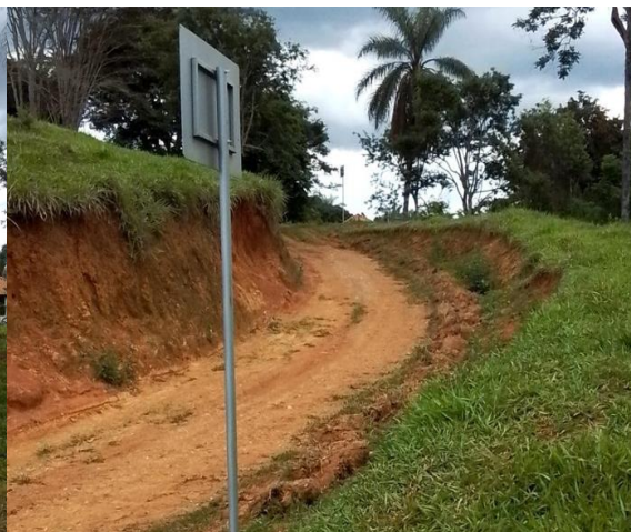
Visita de campo – Placa sinalizadora da Rota de Fuga PE01 . Barragem Sabão I, EuroChem. Serra do Salitre (MG), 19/11/2024
