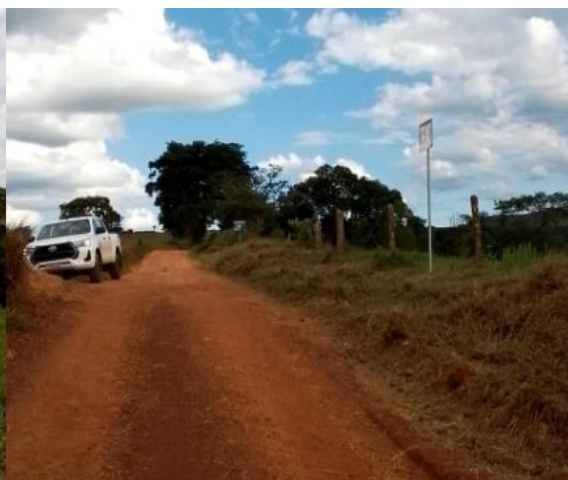
Visita de campo – Placa sinalizadora da Rota de Fuga PE03 Francelino. Barragem Sabão I, EuroChem. Serra do Salitre (MG), 19/11/2024
