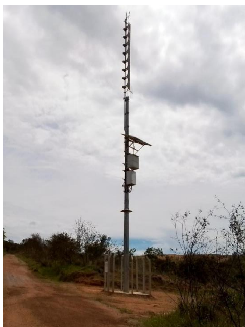
Visita de campo - Instalação da Sirene 290-EC-006 . Barragem Sabão I, EuroChem Salitre. Serra do Salitre (MG), 19/11/2024
