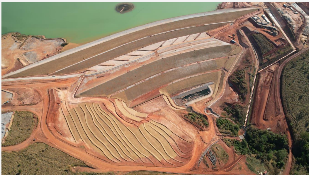
Barragem Sabão I
