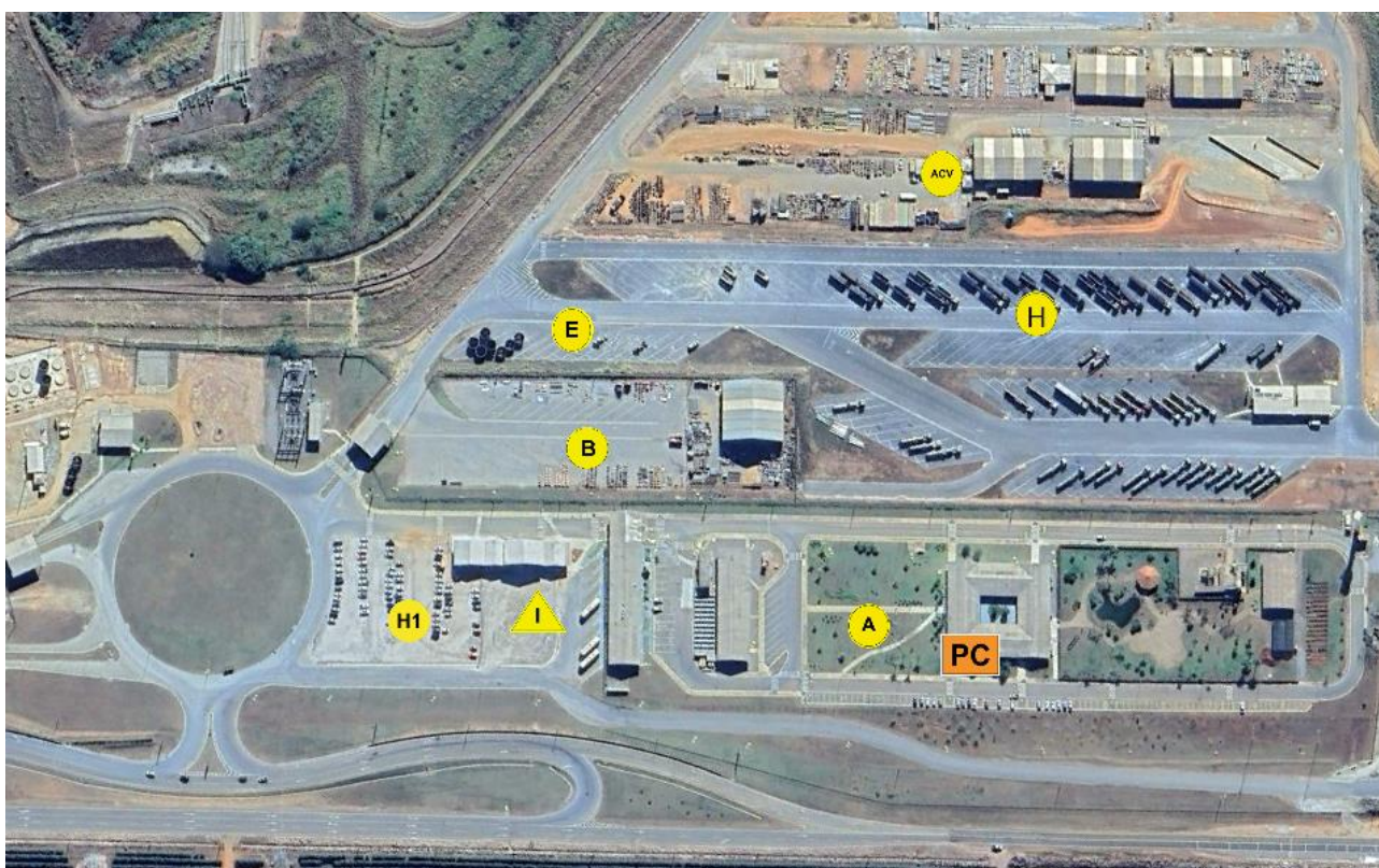
Figura 9.2 - Instalações físicas do SCO - PAEBM Barragem Sabão I - Complexo Minerio Industrial de Serra do Salitre.
